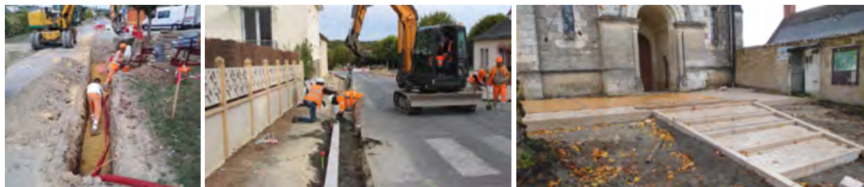
Les travaux place du château d'eau, route des Essards et sur le parvis de l'église
